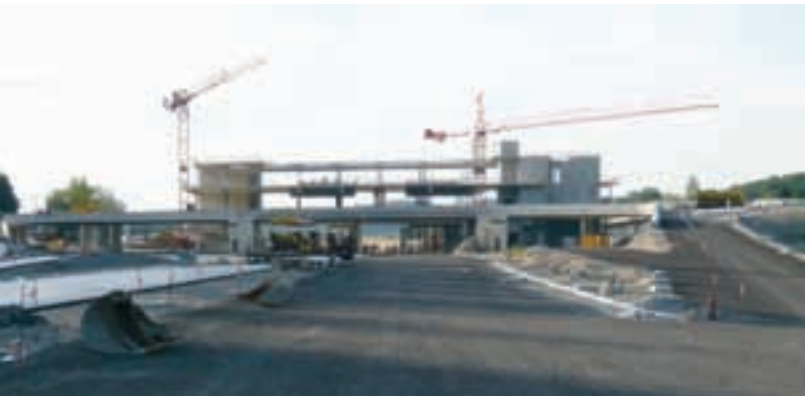
Blick Fahrtrichtung Zürich - Stand der Arbeiten am 20. Juni 2008
