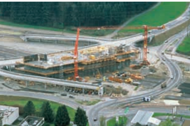
Baustelle Sommer 2008 - Baumeister: Leuthard Bau AG, Merenschwand/Affoltern a.A.
