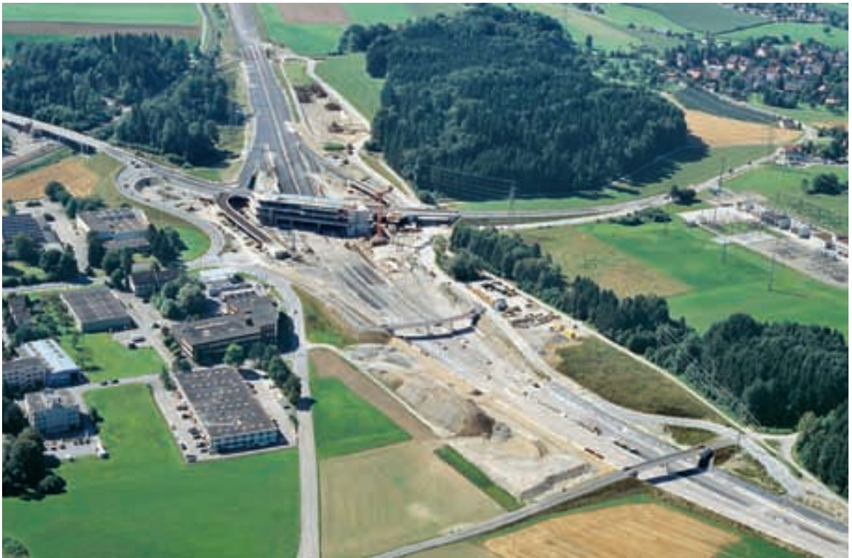
Blick auf Autobahn und Baustelle Fahrtrichtung Zug - Aufnahme Desair-Foto 31. Juli 2008
