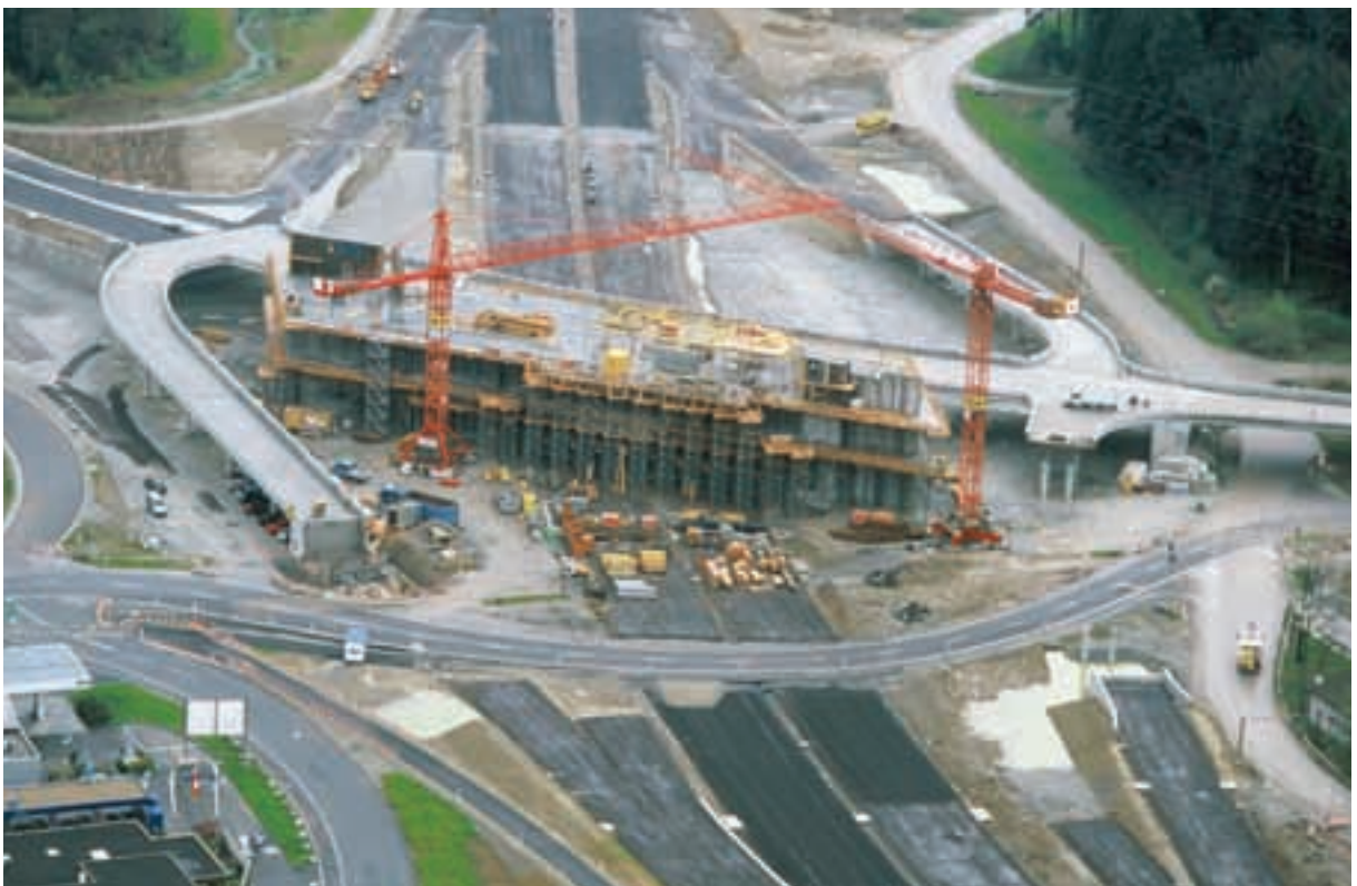
Leuthard Bau AG im Element - Baustelle im Sommer 2008
